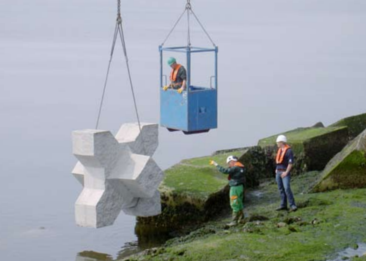
In juni 2008 zijn de eerste eco-Xblocs geplaatst bij de havenpiers van IJmuiden.
